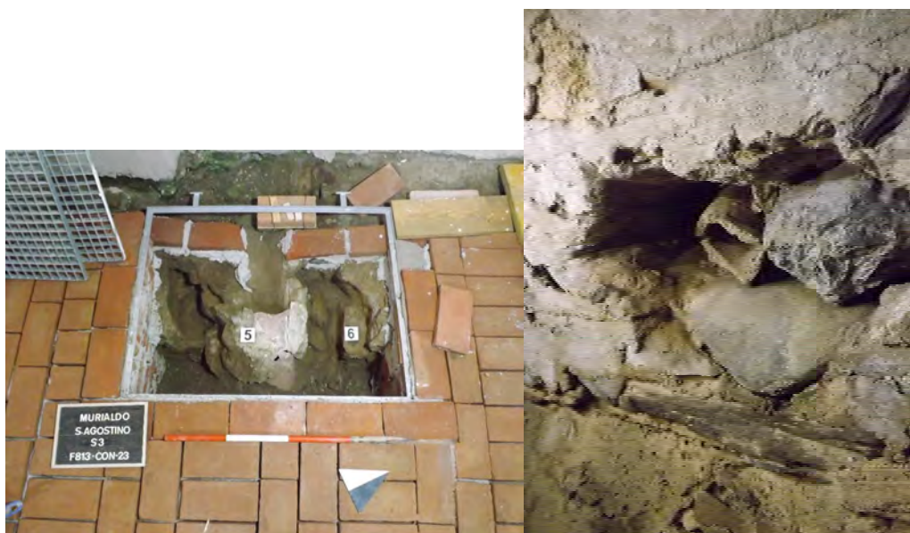
Fig. 9. Saggio 3 a fine scavo e particolare del condotto US 5 che sbuca dalla volta dell'ambiente interrato di fondo.
