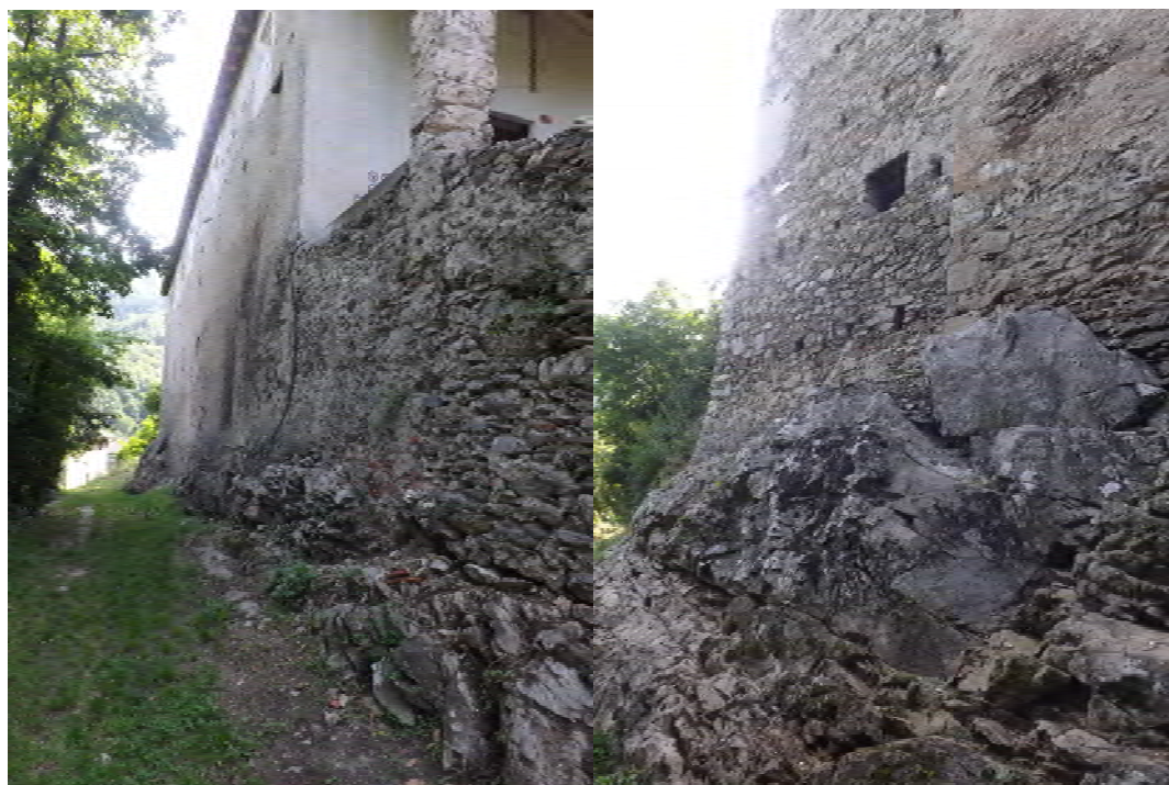
Fig. 4. Infilata della parete est e dettaglio del punto di cesura tra il corpo principale dell'Oratorio e l'aggiunta della canonica.
