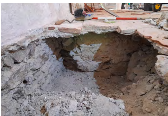
fianco del muro d'ambito originario
