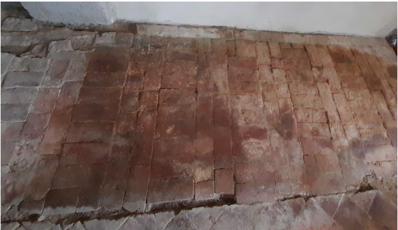
Tipologia ricorrente a mattoni rettangolari disposti a 2 corsi longitudinali e 1 trasversale
